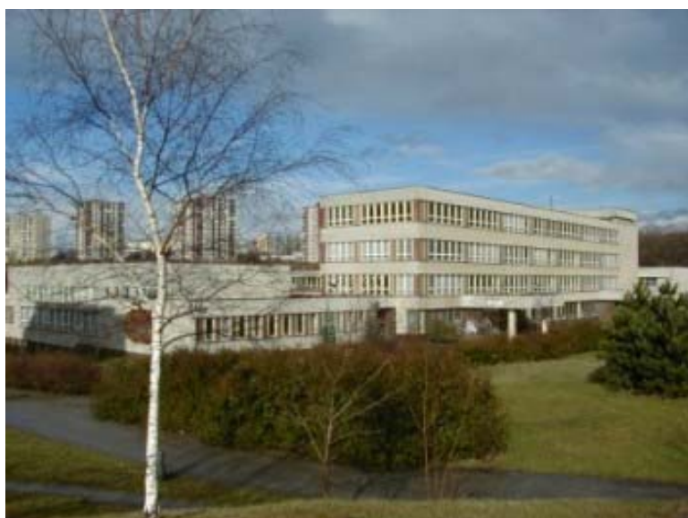
Škola v Praze s rekonstruovaným topným systémem v roce 2000 ©Vladimir Sochor
