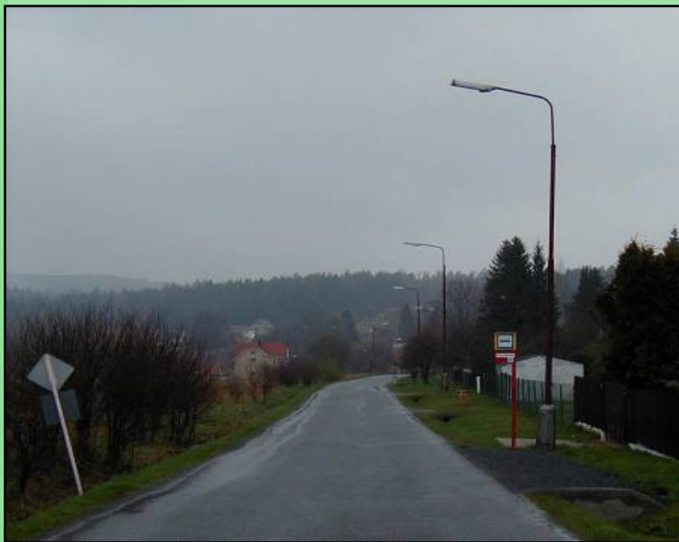
Soustava VO před rekonstrukcí
